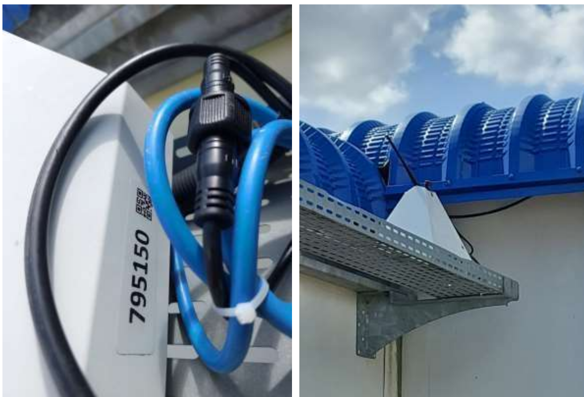
Figura 3. Localização estação de monitoramento da qualidade do ar
